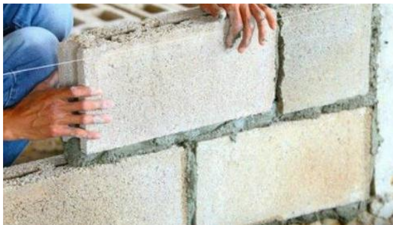
СЛИКА 7. Зидање блоковима од папира FIGURE 7. Masonry blocks of paper
